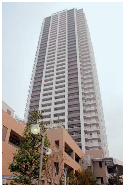
ヴィナシス金町 (シーリング防水工事)
