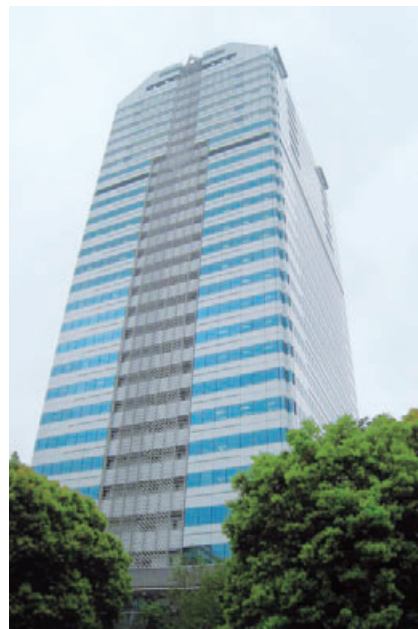
紀尾井町ビル外壁シーリング改修 (リニューアル工事)
