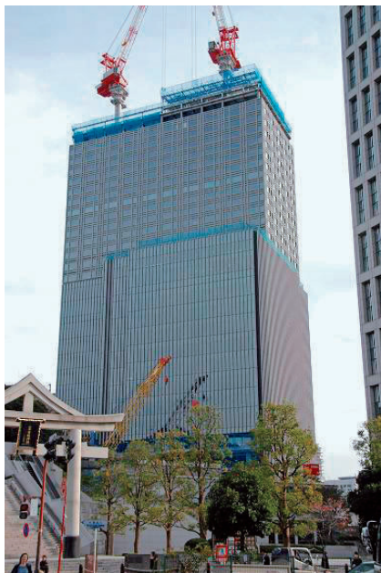
永田町二丁目計画 (シーリング防水工事)
