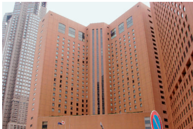
ハイアットリージェンシー東京 (リニューアル工事)
