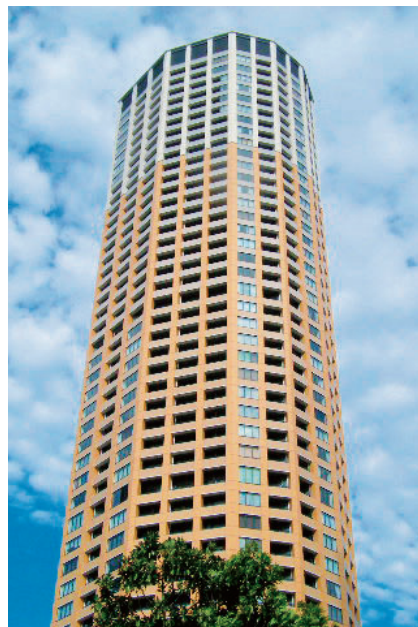
中目黒アトラスタワー (シーリング防水工事)
