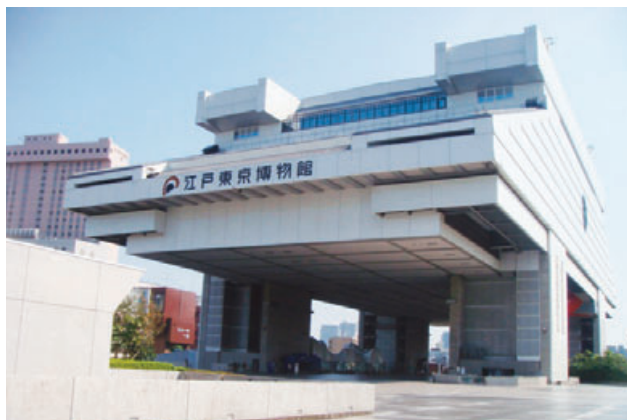
東京都江戸東京博物館外壁改修 (リニューアル工事)
