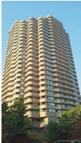
御殿山トラストコート 外壁改修工事 (直接受注工事)
