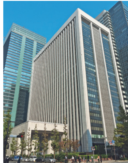
三菱UFJ銀行本館 (改修工事)
