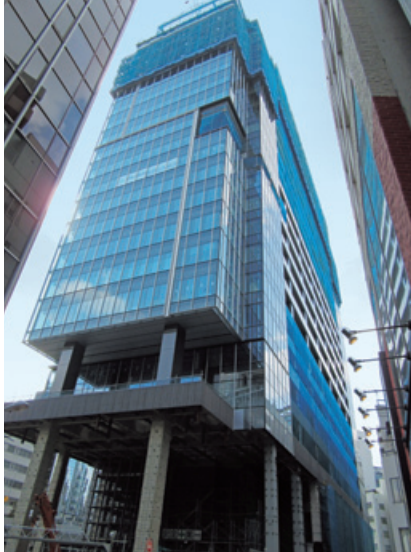
(仮称) 南平台プロジェクト (新築防水工事)
