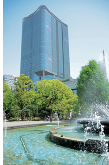
東京ミッドタウン 日比谷 (新築防水工事)
