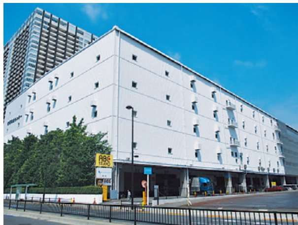
有明物流センター外装改修工事（直接受注工事）
