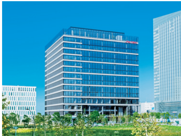
資生堂グローバルイノベーションセンター（新築防水工事）
