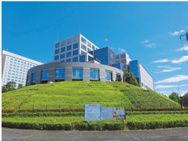
TBC C棟屋上防水工事（改修）
