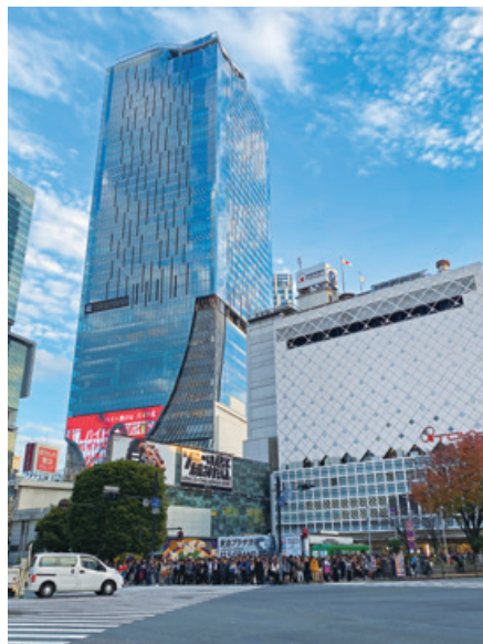
渋谷駅地区駅東棟街区開発計画（新築防水工事）
